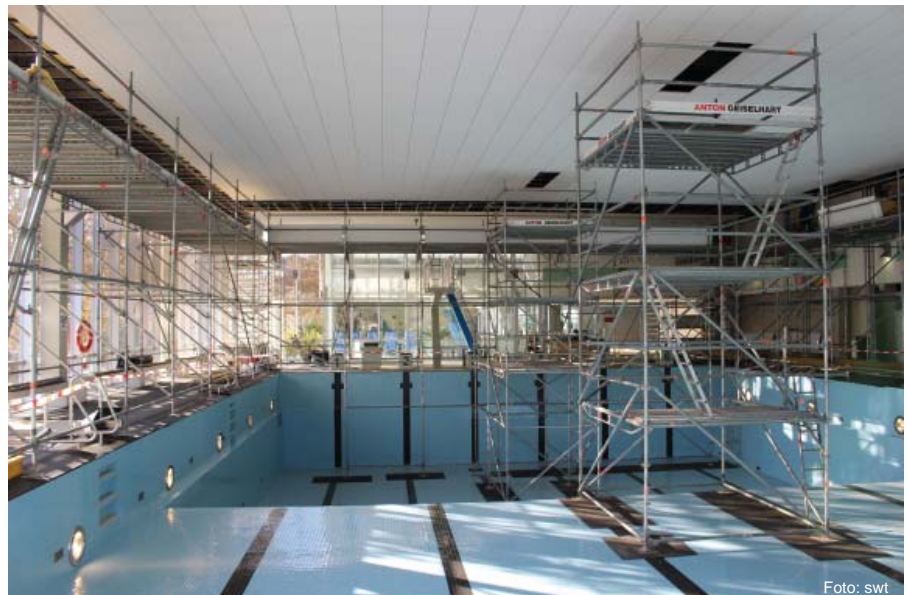
Sanierung Hallenbad Nord 2018
